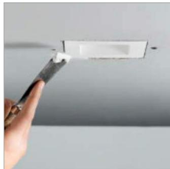
Στοκάρουμε και βάφουμε φωτιστικό και γυψοσανίδα με χρώμα της επιλογής μας. Plaster spot and wall and paint with desired color. Штукатурим, затем красим светильник и стену любым цветом по вашему выбору.
