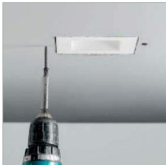
Τρυπάμε γυψοσανίδα και έλασμα φωτιστικού και βιδώνουμε. Screw the spot together with the plasterboard. Просверливаем гипсокартон вместе с прижимными пластинами светильника и крепляем их шурупами.
