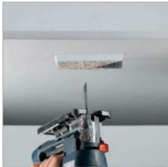
Σημαδεύουμε και κόβουμε με σέγα το άνοιγμα στη γυψοσανίδα. Take measurements and cut the plasterboard. Намечаем отверстие на стене из гипсокартона и вырезаем его с помощью электролобзика.
